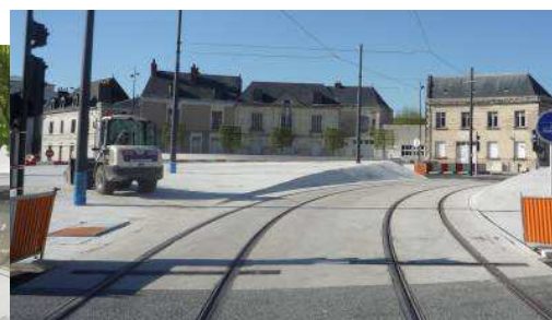
Place de la Tranchée
