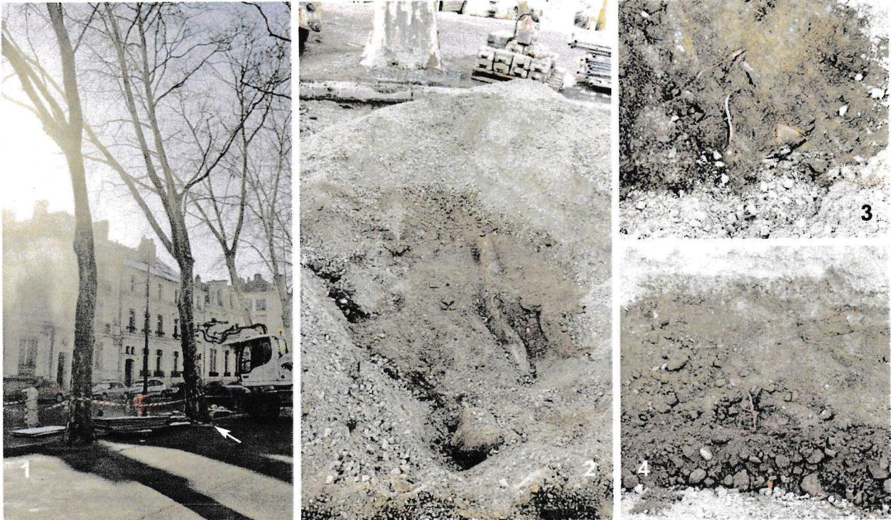
1 : vue générale sur l'arbre inspecté, 2 : racine charpentière oblique sur une grande partie de la longueur de la tranchée. 3 : racines d'exploration sur la marge de la tranchée vers la chaussée, petites racines non ligneuses à une cinquantaine de cm de profondeur.
